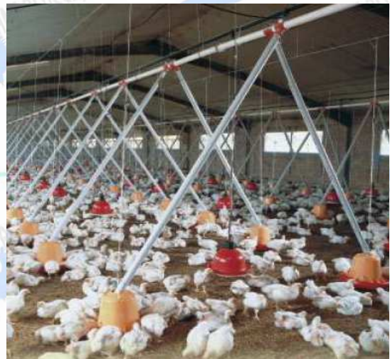
DETALLE DEL TRANSPORTADOR DE PIENSO AUTOMÁTICO Y BEBEDERO-
